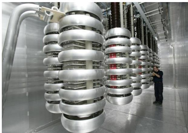
Figura 3. Elemente de semiconductoare IGBT dispuse modular într-o stație de conversie actuală
