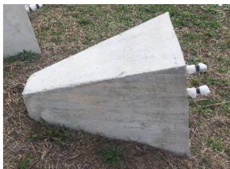
Figura 41 - Fundație de tip trunchi de piramidă
