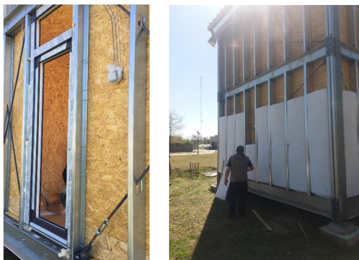
Fig. 3. Montajul închiderilor de perete: sistemul OSB + vată PET
