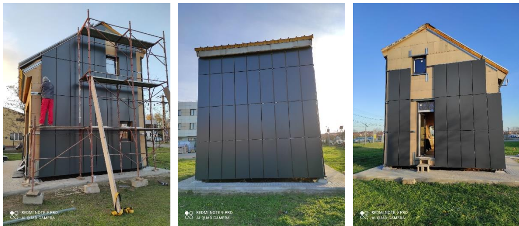
Fig. 7. Montajul casetelor de închidere din aluminiu
