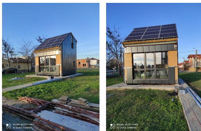
Fig. 9. Montajul panourilor fotovoltaice
