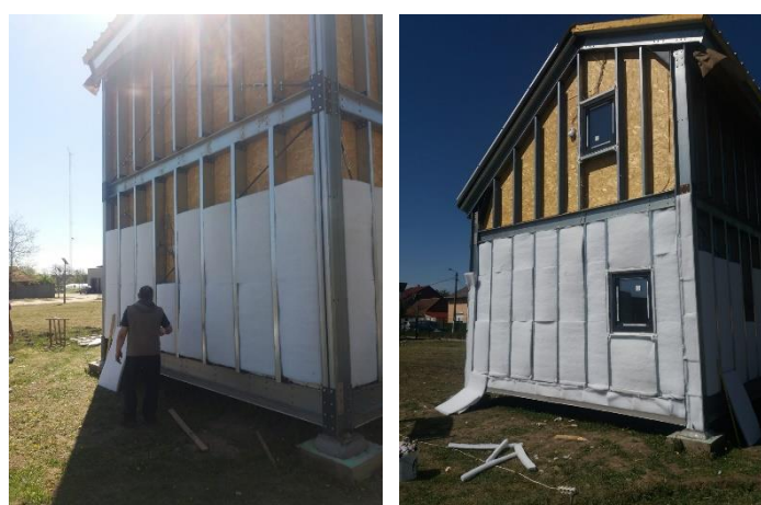
Fig. 5. Montajul termoizolației: vatelină din fibre poliester PET
