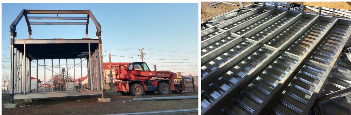
Fig. 1. Aspecte de la montajul și finalizarea structurii de rezistență (a) montarea tablei de sub pardoseala parter
