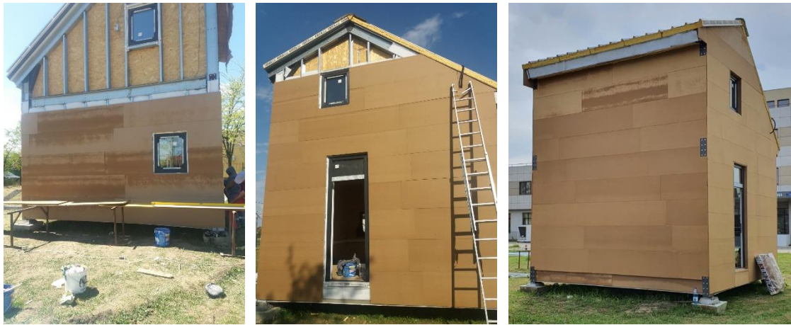
Fig. 6. Montajul termoizolației exterioare: plăci fibrolemnoase
