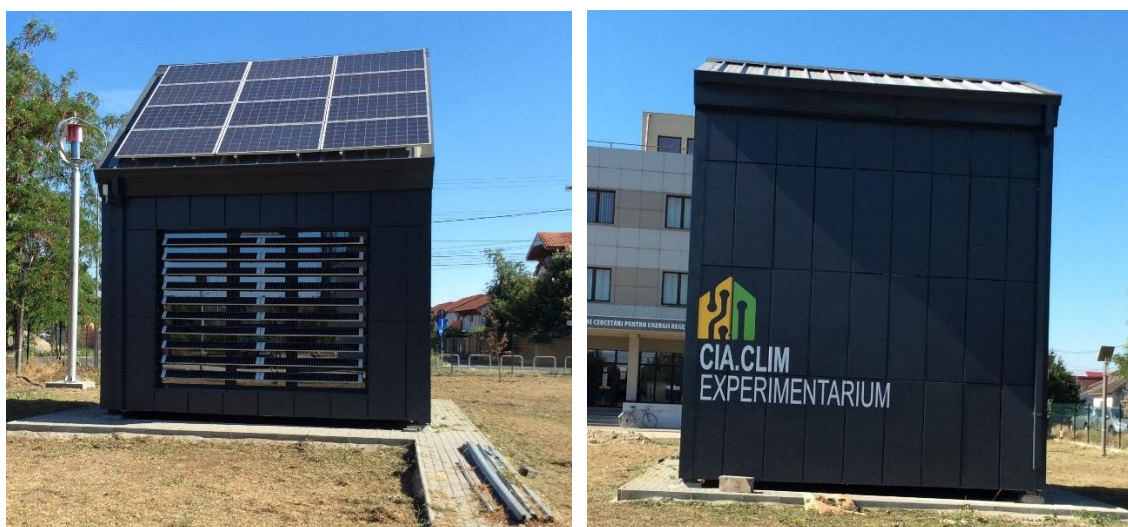
Fig. 3. Fațadele nord și sud ale Laboratorului EXPERIMENTARIUM
