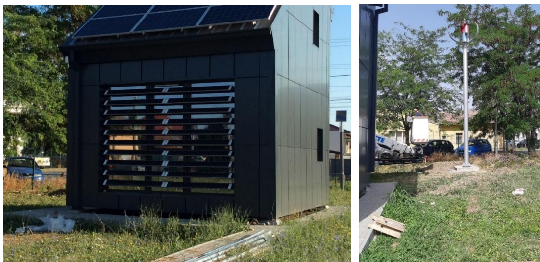
Fig. 4.1. Montajul lamelelor fotovoltaice și a turbinei eoliene
